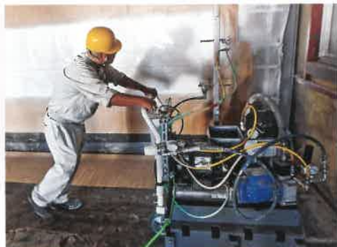
自社で手掛けた半自動型の塗装ロボットで作業する職人。全自動タイプも開発予定だという。「作業をロボット化すれば、例えばメンテナンスやカートリッジを売るシステムなど、新しいビジネスモデルが確立できるかもしれません」
